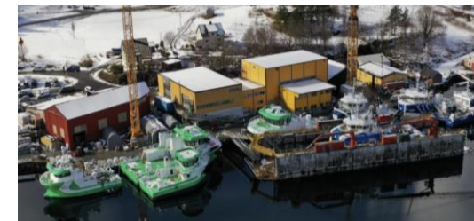
Sletta Verft - overgang til hybrid og elektriske servicebåter
